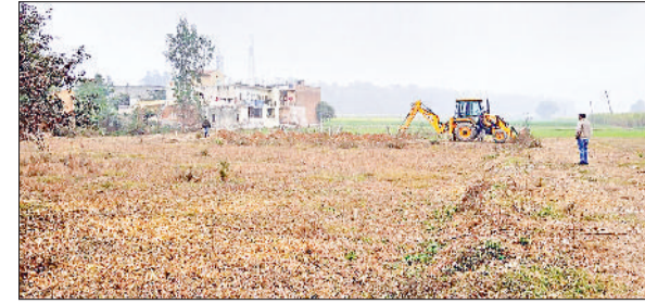
अंबाला। अवैध कॉलोनी में सड़कों को ढहाती जेसीबी।
